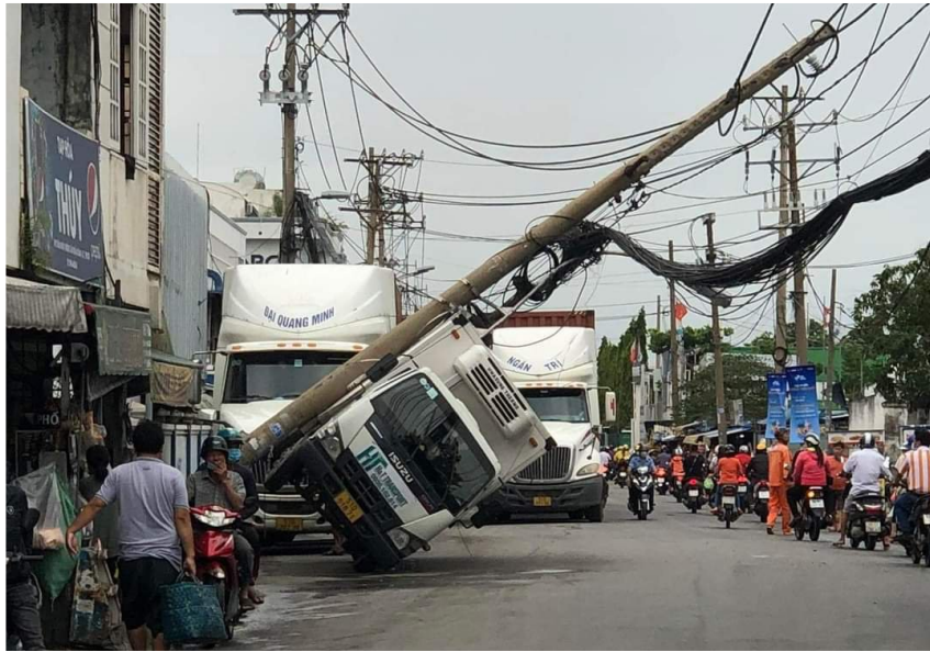
Hình 2: Hình chụp thực tế tại hiện trường vụ xe container quệt trúng đường dây thông tin gây ngã đổ ngã trụ điện.
