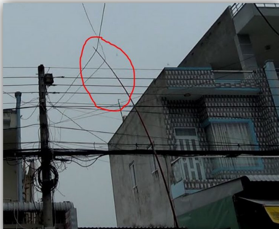
Hình 9: Trường hợp dây vượt đường không đạt độ cao tác động vào cần đo độ cao
