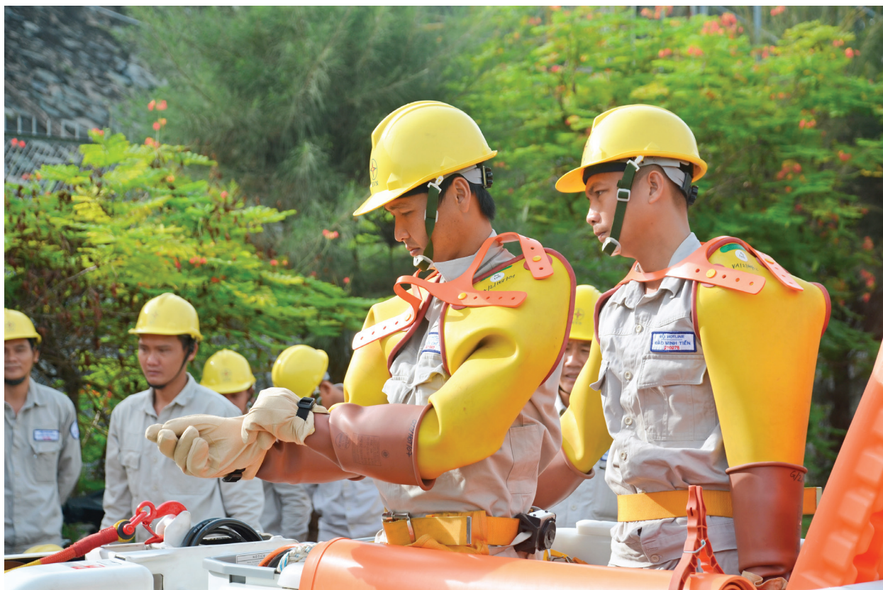
Công nhân đội Hotline chuẩn bị thi công trên đường dây đang mang điện. Ảnh: H.Hợp
