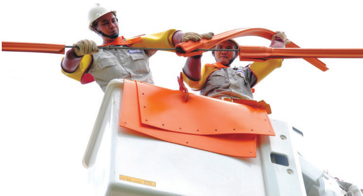
Công nhân đội Hotline chuẩn bị thi công trên đường dây đang mang điện. Ảnh: H.Hợp
