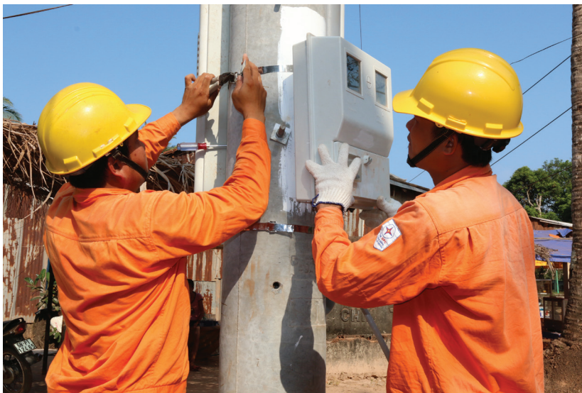
Công nhân Điện lực lắp đặt công tơ điện tử
