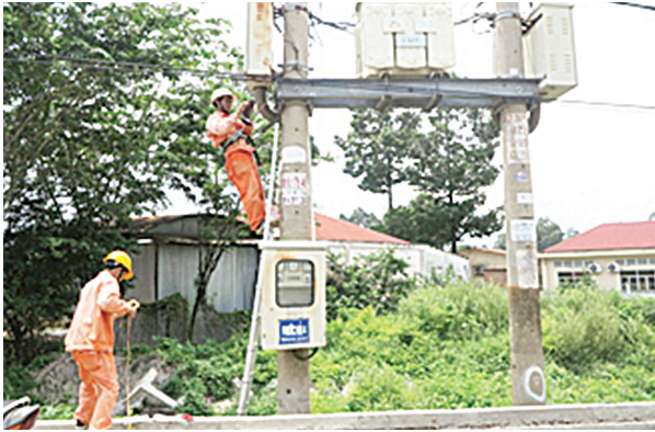
Công nhân Điện lực Long Thành thực hiện đo tải trạm biến áp.
