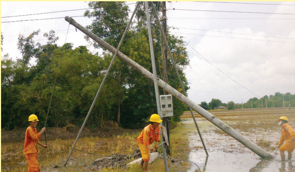
Công nhân Điện lực Cần Đức dựng trụ điện tại vùng nông thôn.
