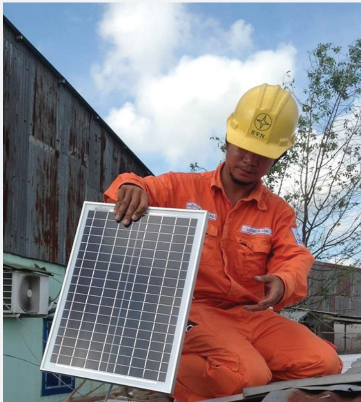
Công nhân Điện lực Cái Răng đang lắp đặt bộ đèn năng lượng mặt trời
