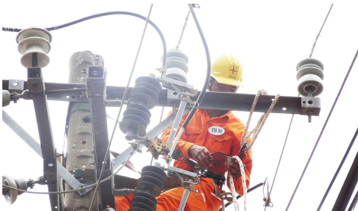
Ngành Điện thường xuyên thực hiện sửa chữa, bảo trì lưới điện nhằm giảm tổn thất điện năng
