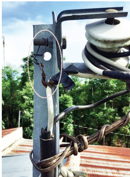
Vị trí khách hàng vi phạm sử dụng điện bằng hình thức câu móc trực tiếp
