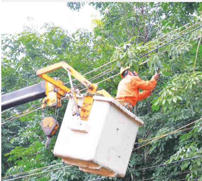
Công nhân Xí nghiệp Điện cao thế Đồng Nai đang phát quang HLATLĐCA.
