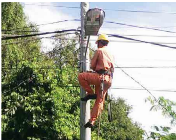
Công nhân Điện lực Đất Đỏ hỗ trợ lắp đèn chiếu sáng cho tuyến đường nông thôn
