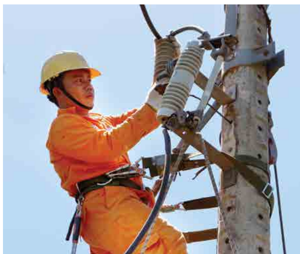
Sửa chữa lưới điện tại Hậu Giang
