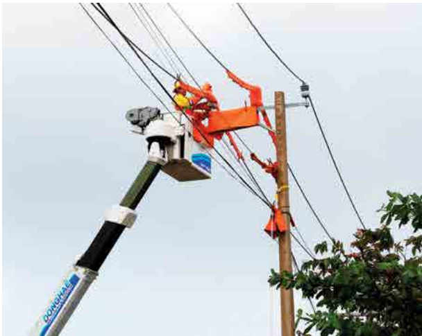
Đội sửa chữa điện nóng thay sứ cách điện trên 1 nhánh đường dây 22kV đang vận hành
